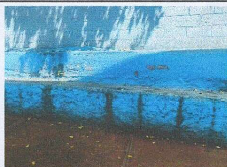
Foto 4: Reparación de gradas limpieza y sustitución de repello
