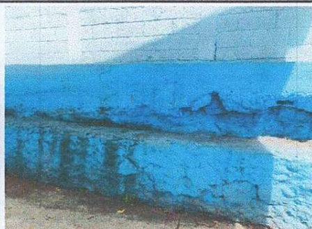
Foto 3: Reparación de gradas limpieza y sustitución de repello
